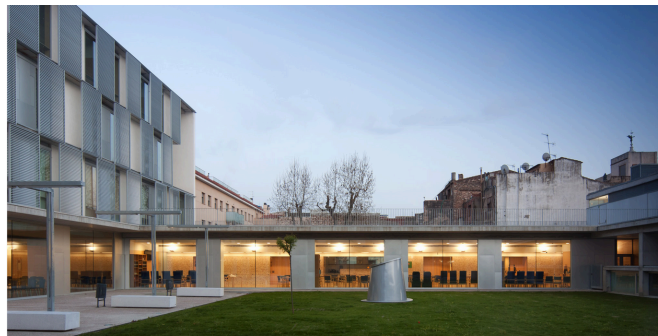
Plataforma de servicios de Vilanova i la Geltrú (2011) Arq. Pínearq
