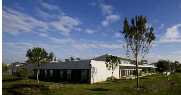
Edificio sociosanitario Parc Martí i Julià, Salt. Arq. Pínearq & Brullet de Luna Arquitectes
